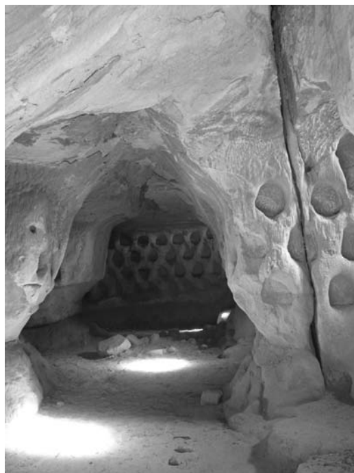
Figura 5 Interior de la misma cueva de los Llanos. Se observa la fractura abierta que desgaja el tabique de roca externo. La fractura es posterior a la labra de los nichos. Las diaclasas asociadas posteriores están parcialmente cerradas. Las trazas son decamétricas. Buzan 70–80° Sur. Foto CSS, 2007.
